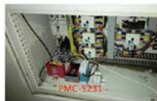
圖4. PMC-5231-4GC電錶集中器安裝位置
